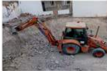
EXCAVACIONES Y DERRIBOS
